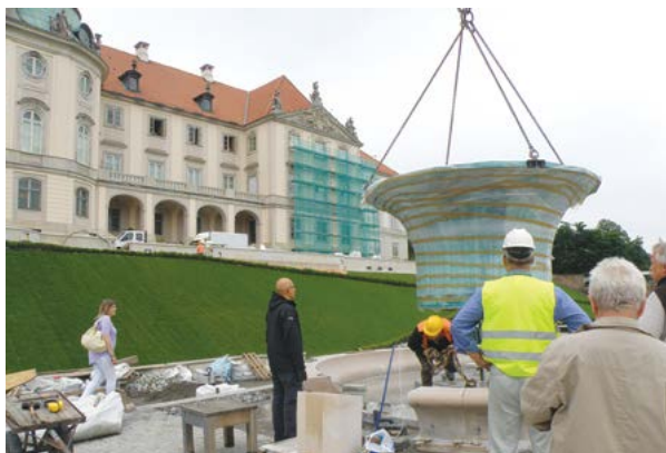
Prace przy rewitalizacji Ogrodu Górnego, 2014
